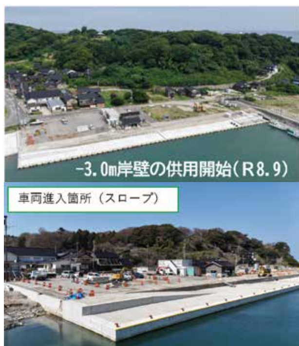
図-4 -3.0m岸壁の復旧状況
