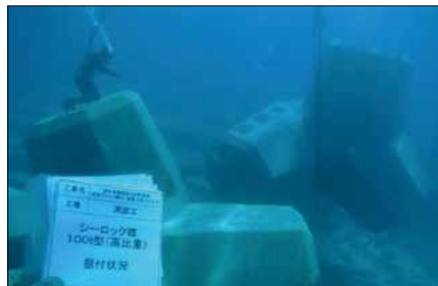
写真-3 消波ブロック(高比重)据付状況
