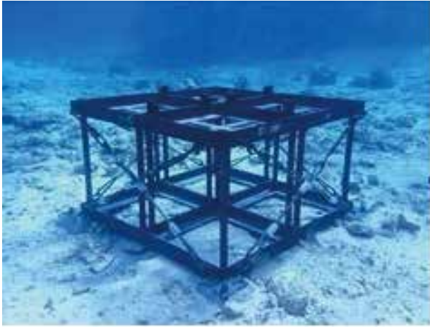
写真－１ 設置完了後の新規鋼製架台
