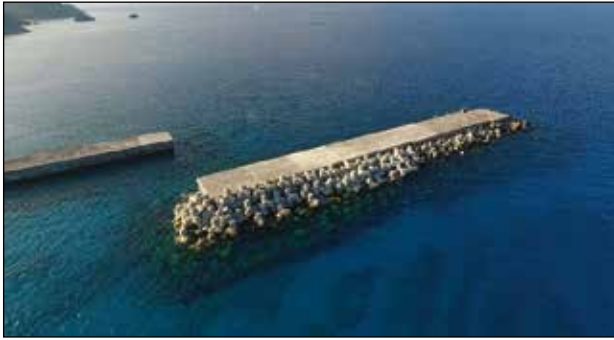
写真－4 改良工事を終えた第2沖防波堤
