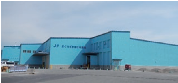
写真一 三 冷蔵施設(R5供用)
