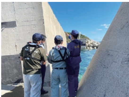
写真 現地調査状況(台風により転倒した防波堤)
