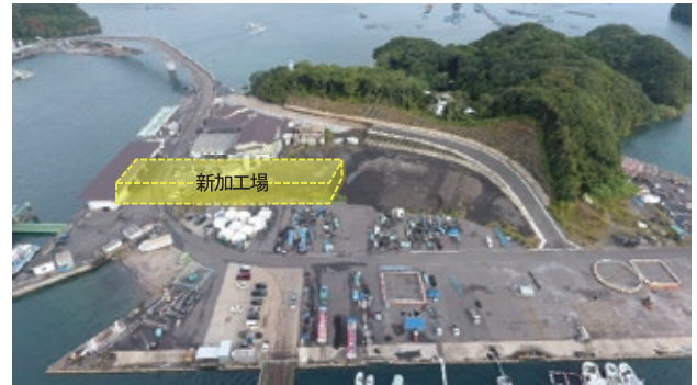
写真-10 竹島地区全景
