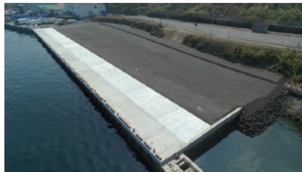
写真-14 -3m岸壁(陸揚)(R6完成)
