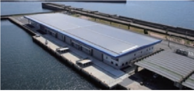
写真一 二 高度衛生管理型荷さばき所(H28供用)
