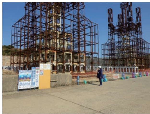
写真一5 工事確認状況(大型魚礁製作)
