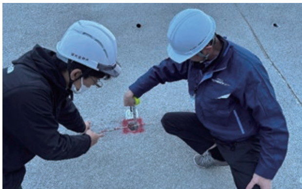
※右側が筆者 写真－２ 道路法面工吹付厚の確認
