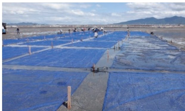
図－３ 漁業者による被覆網の設置状況(玉名市)
