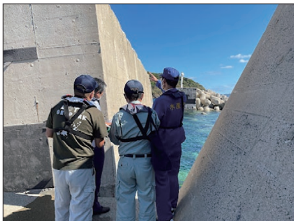
写真 現地調査状況(台風第11号により転倒した防波堤)
