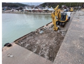
岸壁の切り下げ工事(R7.1)
