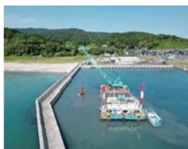
泊地の浚渫工事(R6.6)
