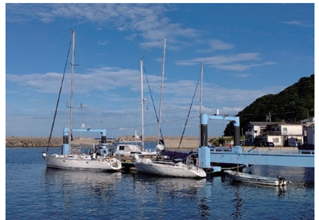
写真－2 漁船用浮棧橋への係留状況
