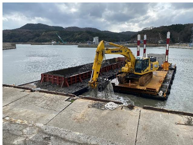
写真一11 組立台船バックホウ浚渫船
