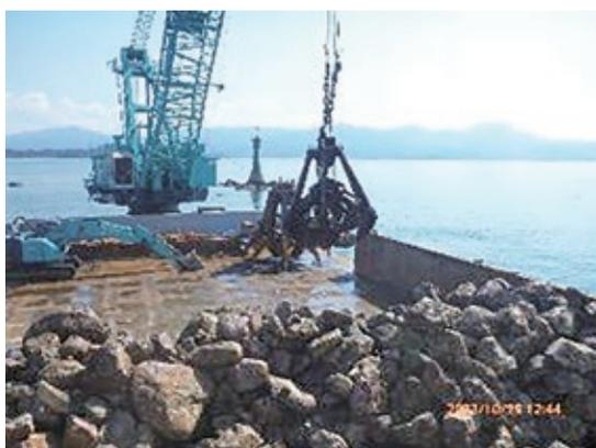
写真5 石材の船上仮置き状況
