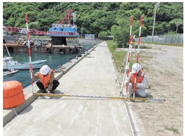
写真一八 エプロン幅の計測状況
