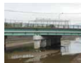
鹿児島県塩釜橋
