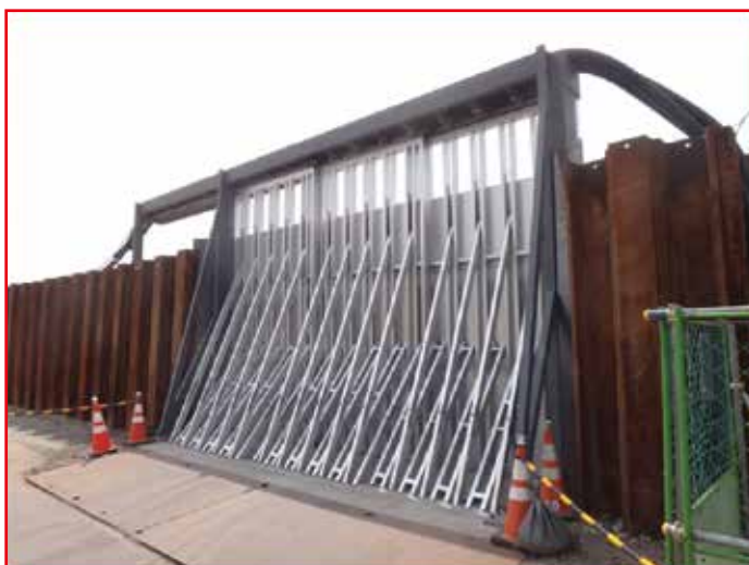
寸 法：幅9.5m×奥行4.3m×高さ4.7m 重 量：2,613kg
