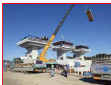
屋根材料を搬入し、クレーンで吊上げ
