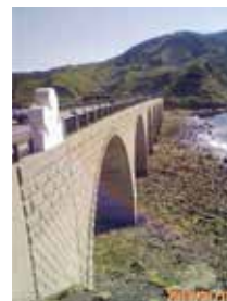
鹿児島県かのこ大橋
