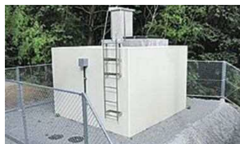
写真四 配水施設(配水池増設)
