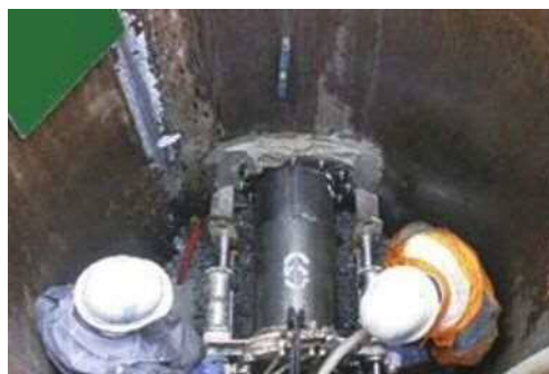
写真三 排水管路施設(小口径推進)
