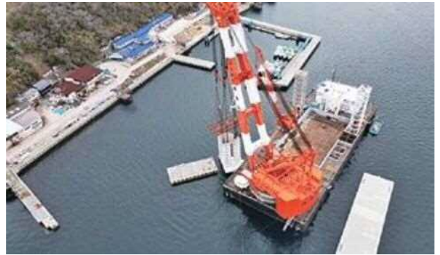
写真1 伊吹漁港におけるケーソン設置工事
