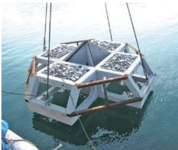
写真6 沈設する増殖礁
