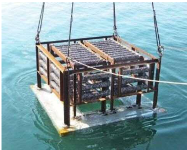
写真5 沈設する増殖礁
