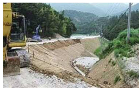
写真五 道路改良
