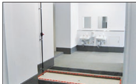
手洗い場、長靴洗浄槽
