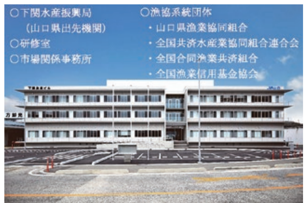
写一 新漁港ビル全景写真
