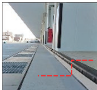
車両侵入防止対策
