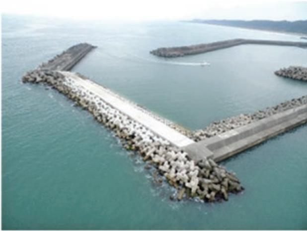
写真一七 防波堤の粘り強い化
