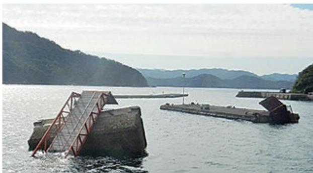
写真－4 浮棧橋の崩壊
