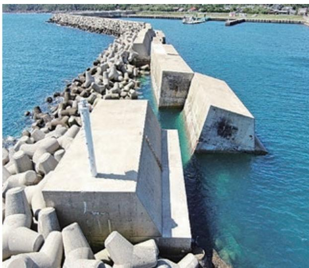
写真－3 防波堤の滑動
