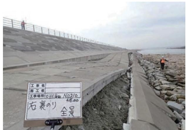
写真-1 海岸堤防の損壊
