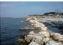
地震により岸壁が倒壊
