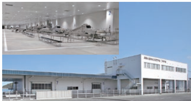
7号荷捌所(外観)
