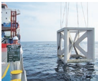
(写真3) 漁場整備工事の監督補助
