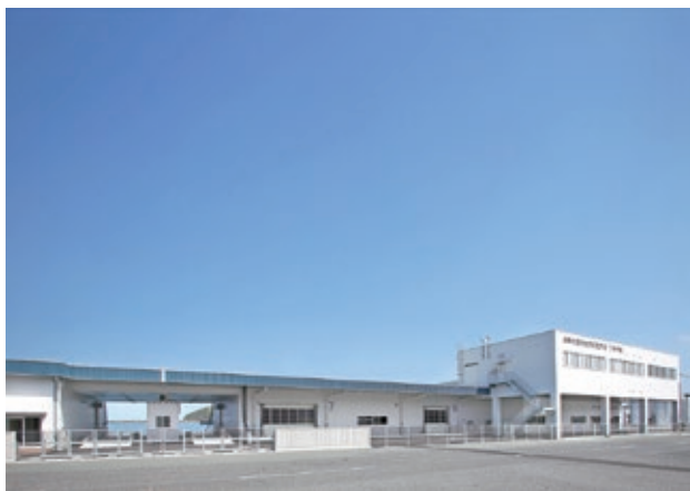
高度衛生管理型 7号荷捌所
