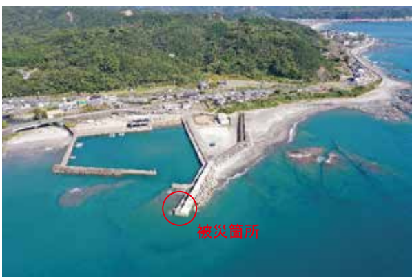
写真-2 漁港全体ドローン空撮 (被災後)
