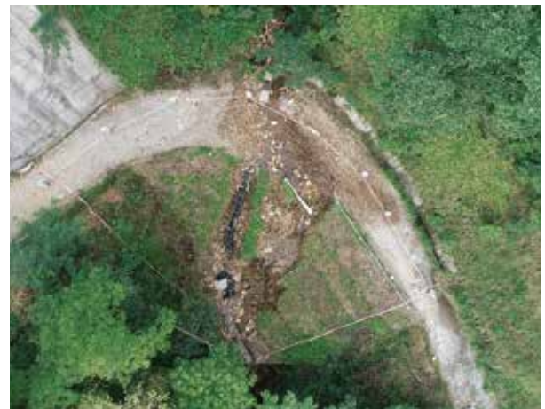
写真-2 林道土砂災害
