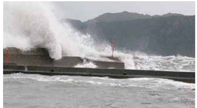
写真-3 台風時の越波状況 (串本町提供)
