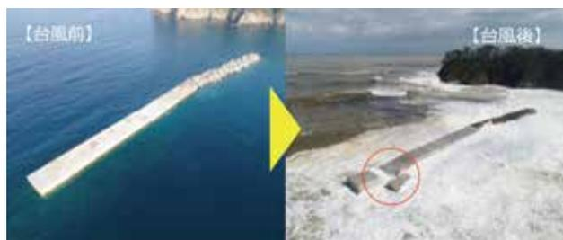
写真-2 台風前後の沖防波堤の変化
