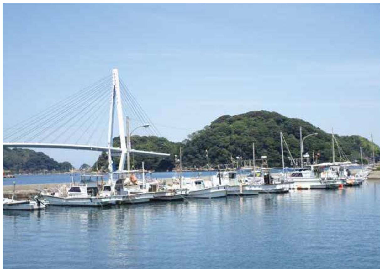
漁港施設における日本最大の斜張橋マリン大橋の架かる浜田漁港（島根県浜田市） [当センター東京本部 松本職員が撮影]
