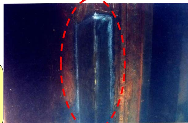
(施工後)鋼板溶接工法
