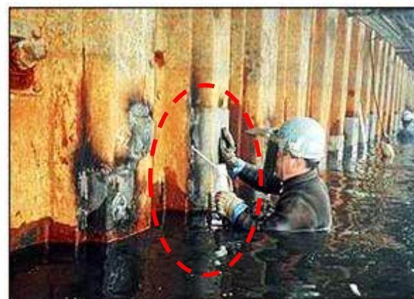
(施工中)鋼板溶接作業
