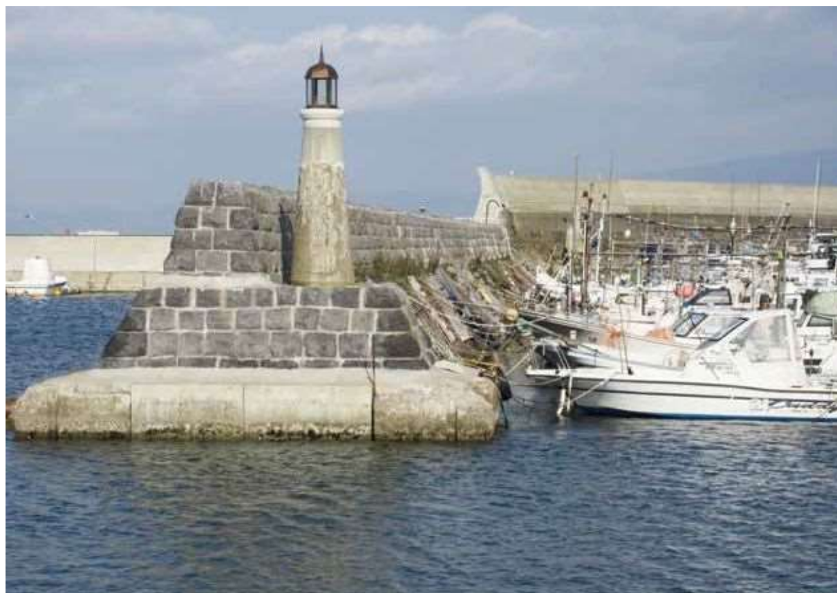
石積防波堤が修復・保全された函館漁港（北海道）
