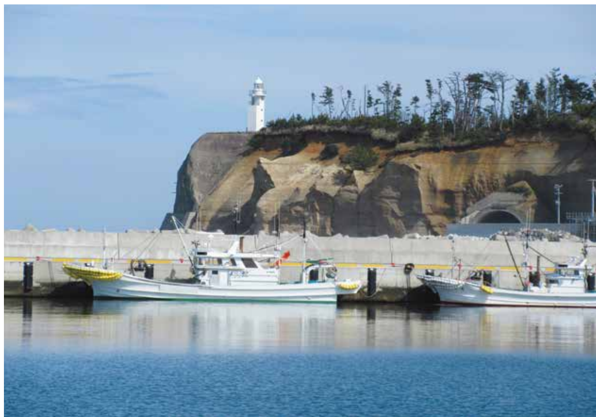
東日本大震災の復旧工事がほぼ完了した福島県松川浦漁港
