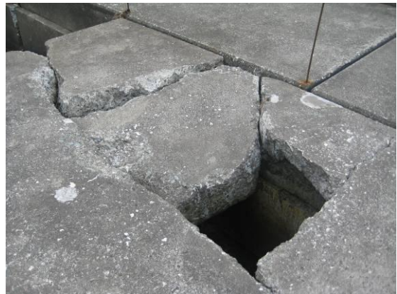
突堤上部工の欠損
