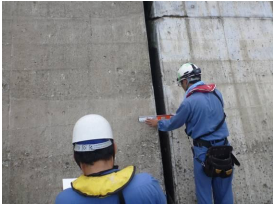
パラペット間の隙間の計測
