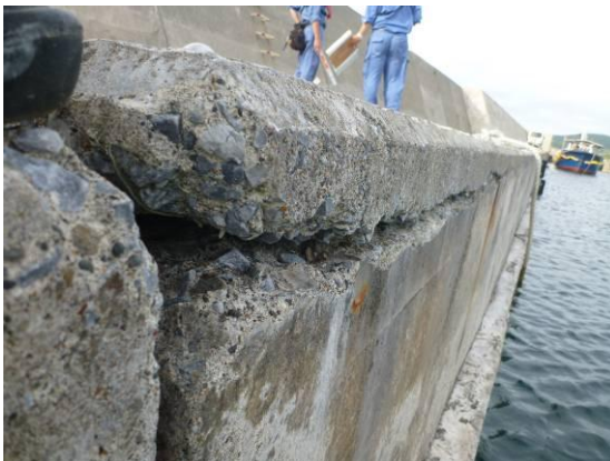
防波堤上部工表面のひび割れ
