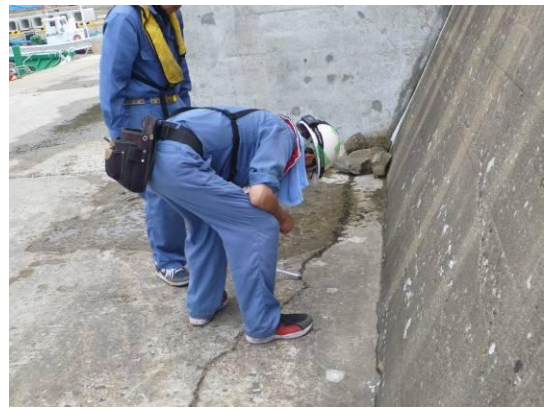
防波堤上部工のひび割れ幅の計測
